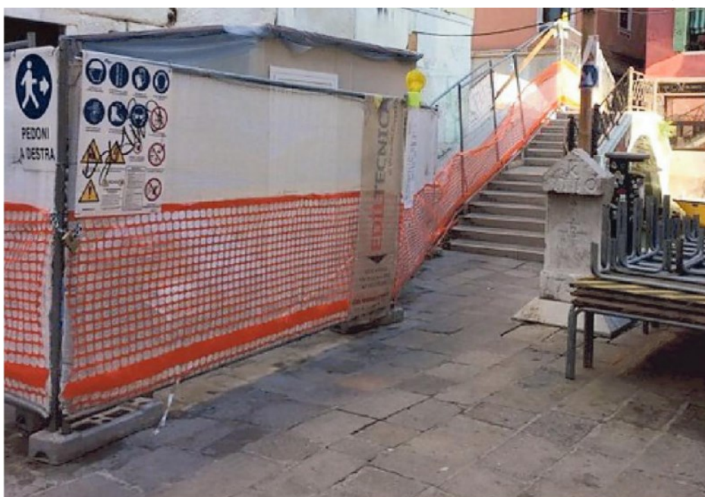
Il cantiere di una ristrutturazione nel centro storico: la città è un cantiere
