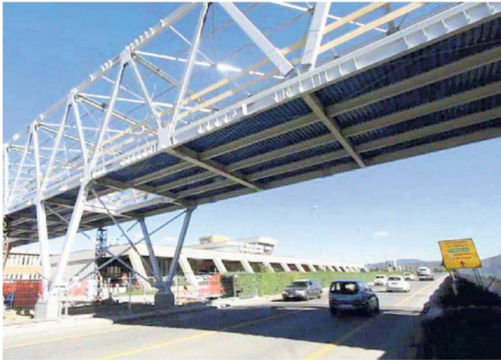
Il polo intermodale del Trieste Airport : dal 19 marzo arrivano i treni a Ronchi
