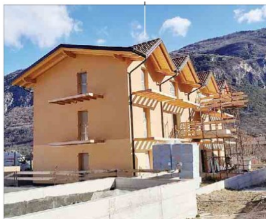
Il cantiere di Chizzola dove il Consorzio Lavoro Ambiente sta realizzando tredici appartamenti, destinati a famiglie numerose, a prezzi agevolati
