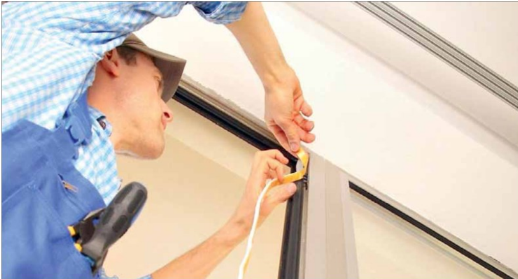
Installazione e manutenzione dei serramenti. Il Decreto Rilancio permette al serramentista di cedere il credito d'imposta
