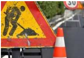
Lavori in corso in Via Ruffio
