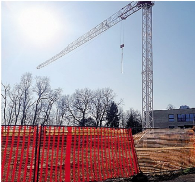
La gru montata in via Sparta, ma il cantiere non è ancora partito
