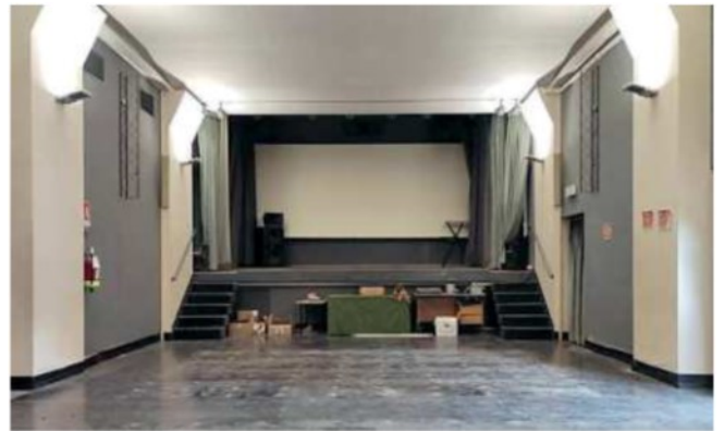
La sala di via Guercino a lavori in corso durante la scorsa estate
