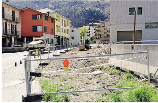
Sono iniziati i lavori lungo via Merizzi
