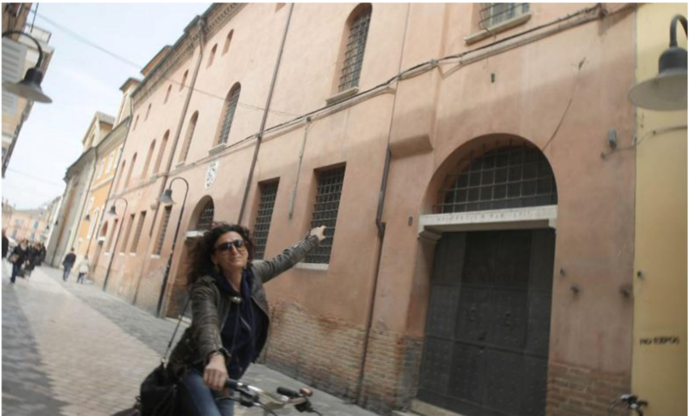
L'edificio in via Diaz: gli uffici sono chiusi e abbandonati ormai da tempo. Residenti e commercianti ne chiedevano il recupero (foto Giampiero Corelli)
