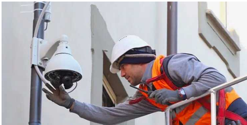
Lavori per la posa di telecamere di videosorveglianza a Vigevano (©Sacchiero)
