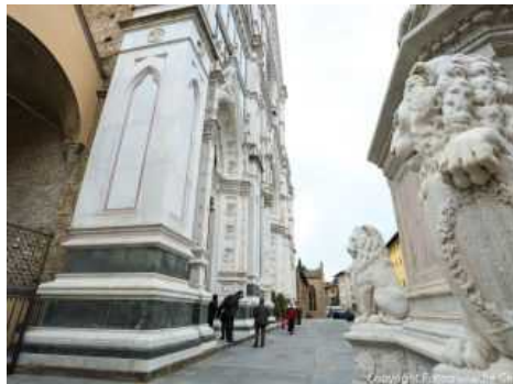
Terremoto, controlli a Santa Croce: non è stato riscontrato alcun danno
