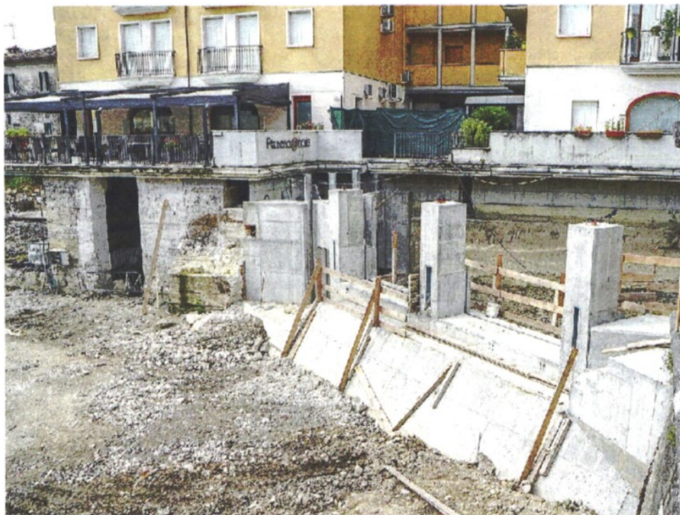
RECUPERO Alcuni dei lavori per il ripristino di centraline elettriche sul Livenza a Sacile
