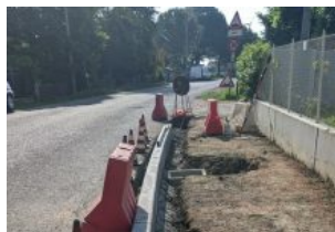
Godo di Russi: Via Croce, partono i lavori per la ciclopedonale
