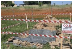
Bagnacavallo. Ritrovato un ordigno bellico durante i lavori per il sottopasso ferroviario
