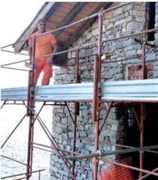
I lavori in corso al tetto della cappella olivetana, uno dei tesori dell'area sacra
