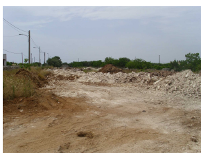
Sbancamenti e lavori
