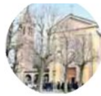
La chiesa di San Giuseppe della frazione della Bemolda
