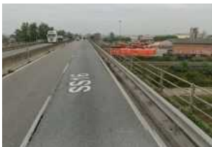
Sostituzione delle barriere sul viadotto Faentina della Ss 16: traffico concentrato su una sola
